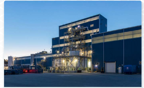
La instalación de conversión de Kings Mountain: esta instalación transforma recursos esenciales de litio en ingredientes críticos para la movilidad, la energía, la conectividad y la salud.
